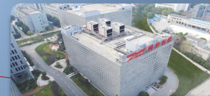
Shanghai KeZhong Data Center
