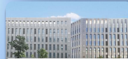
Beijing KeZhong Data Center
