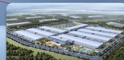
Qingyuan Ruiteng Data Center
