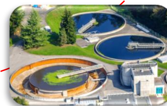
Станция очистки воды
